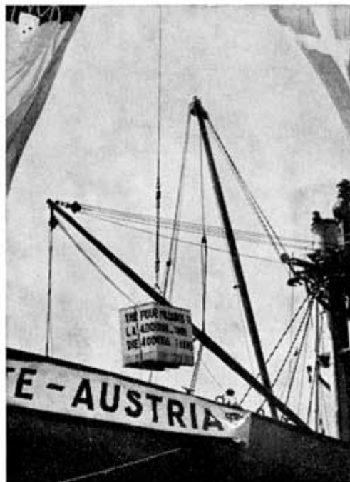
La quattromilionesima tonnellata ERP per l' Austria viene scaricata nel nostro porto
